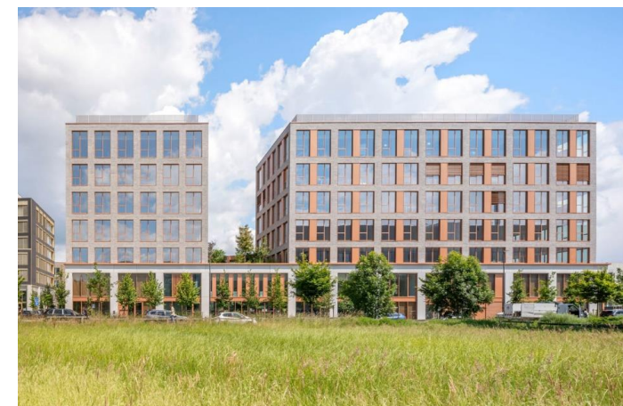
Bâtiment de bureaux à Saclay (91)
