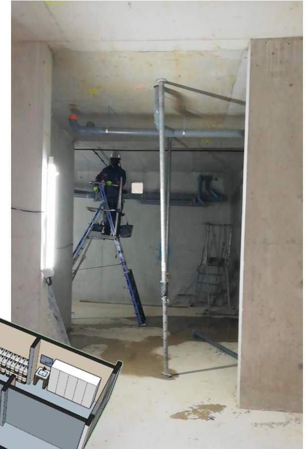
Maquettes 3D du local accueillant l'usine de traitement des urines et photos chantier - STEA
