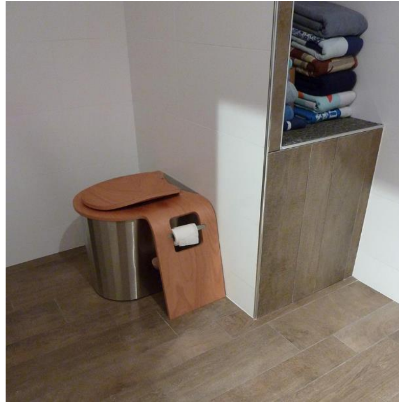
Toilettes sèches à séparation d'urine ; composteur intégré Composteur au même niveau (à gauche - ecodomeo) ou composteur en sous-sol (à droite Clivus)
