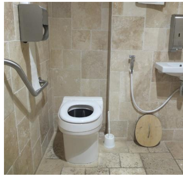
Toilettes sèches unitaire - composteur intégré (modèle Clivus Multrum)
