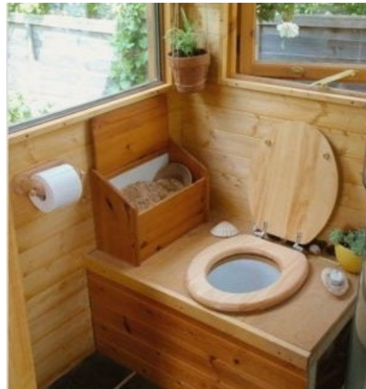
Toilettes sèches unitaire avec composteur à l'extérieur (modèle Séparett à gauche / sur-mesure à droite)
