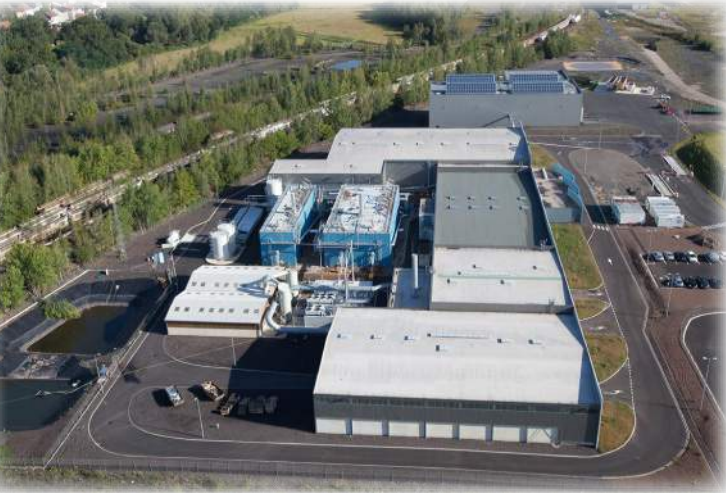
Vue de l'usine (Crédits : SYDEME)
